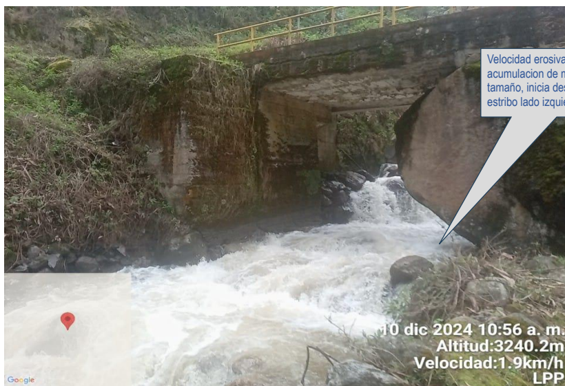
FIGURA N°02: ESTRIBOS DEL PUENTE EXPUESTOS ANTE UNA CRECIDA DEL RÍO CHILAMAYO EN LA MARGEN IZQUIERDA
